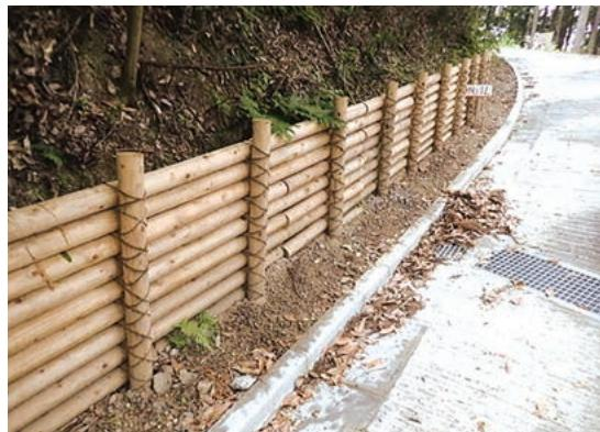
自然環境に配慮し、林道への土砂の崩落防止に、多摩産材を使用しています。(日の出町)
