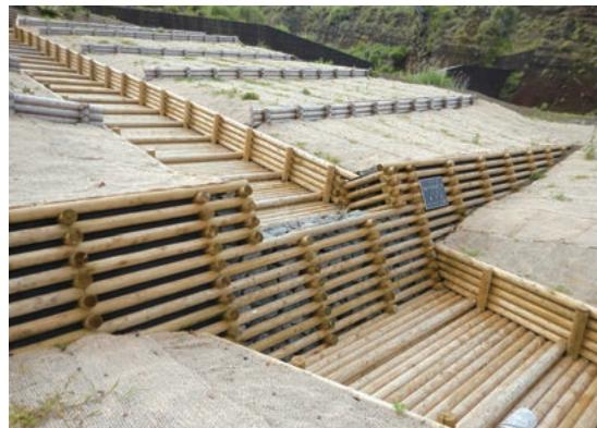
災害復旧を図るための土留め等に、高耐久の加工を施した多摩産材を使用しています。(三宅村)
