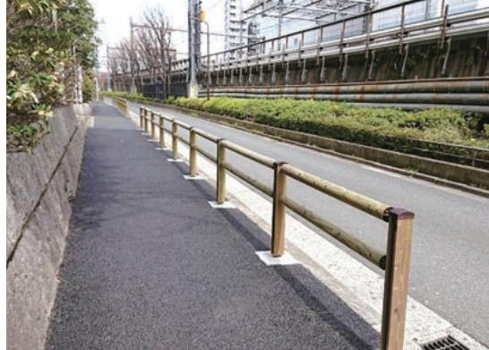
多摩産材に鋼材を併せて耐久性、メンテナンス性を向上させました。都市型デザインの木製防護柵です。(新宿区)
