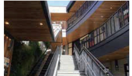
某商業施設の軒天
