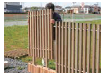
新設のコンクリートブロックに立てる
