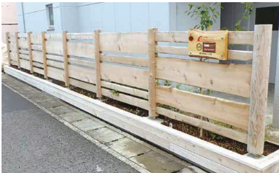
削孔支柱ピン工法による木堀
