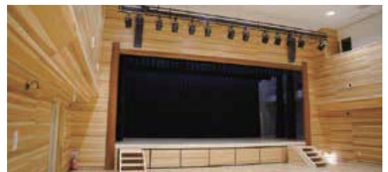
東京の木 多摩産スギ(構造用合板)を使用 (西多摩郡日の出町公民館)
