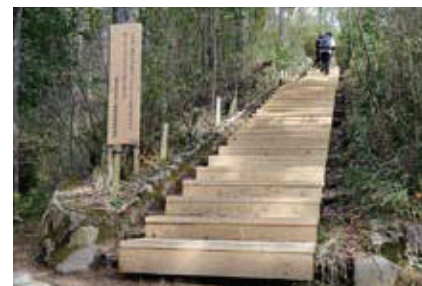
公園緑地を整備する木道・階段
