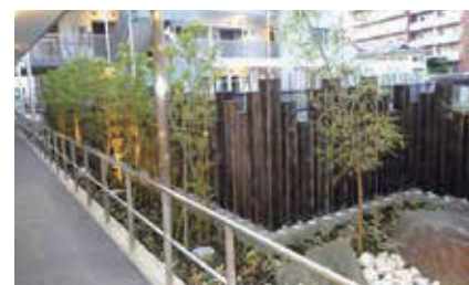
削孔支柱ピン工法による木柵
