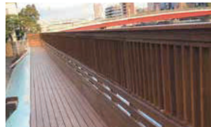
東京の木 多摩産材のウッドデッキと木製フェンス
