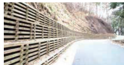
「高耐久木製枠」を使用した土留工
