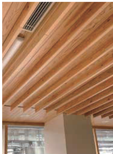
某公共施設の天井ルーバー
