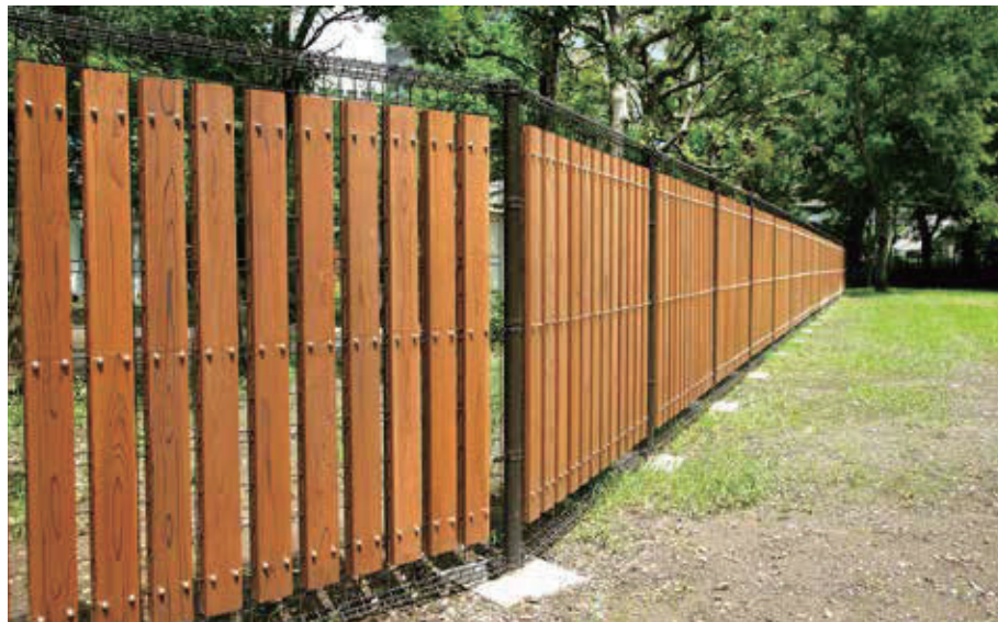
サーモウッドの木製フェンス、耐風圧設計済
