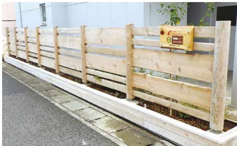
削孔支柱ピン工法による木堀
