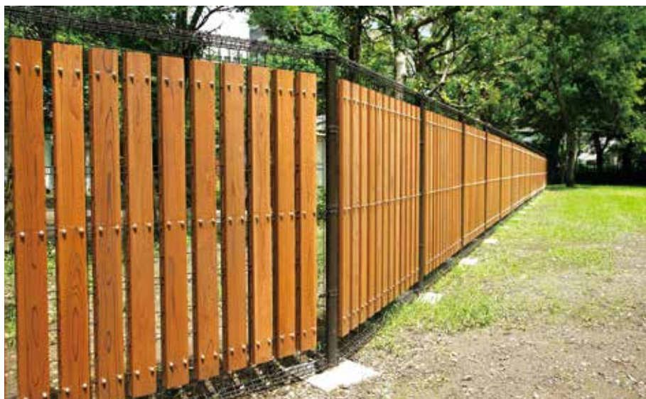
サーモウッドの木製フェンス、耐風圧設計済
