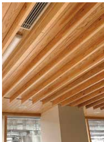
某公共施設の天井ルーバー
