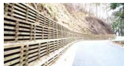
「高耐久木製枠」を使用した土留工
