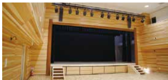
多摩産スギ(構造用合板)を使用 (西多摩郡日の出町公民館)
