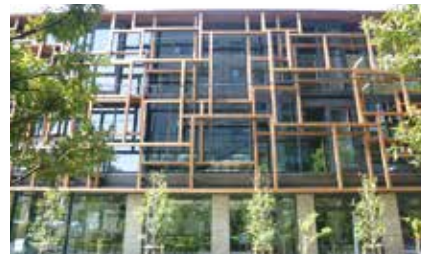
某企業事務所の外装ルーバー
