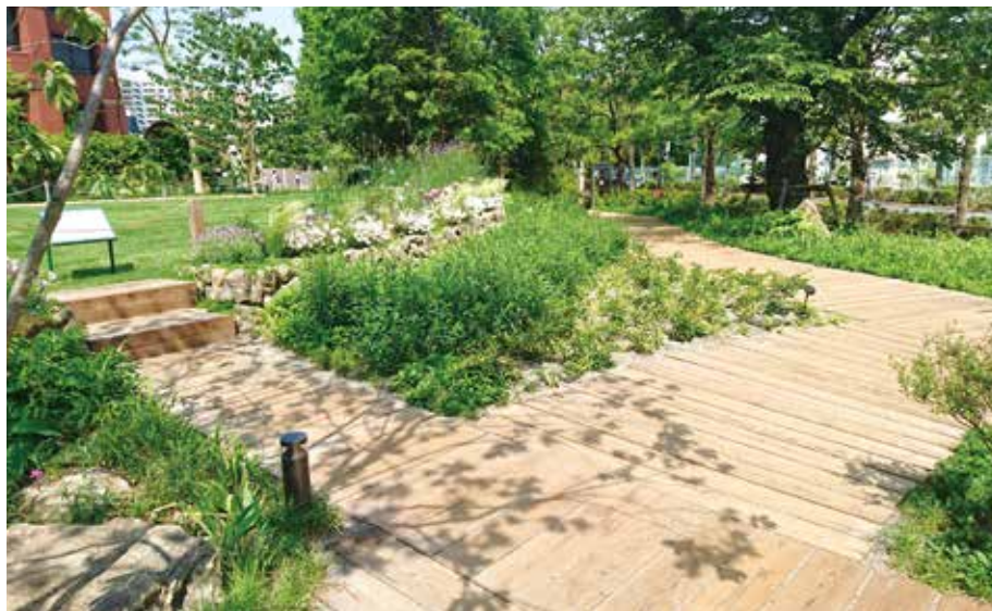
ガーデン枕木を埋設
