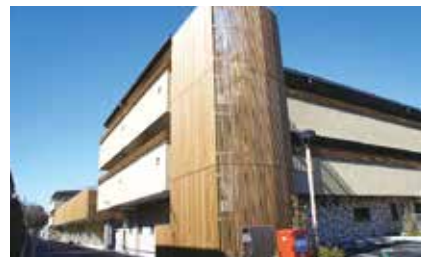
福祉施設の外装ルーバー
