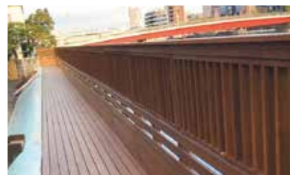
多摩産材のウッドデッキと木製フェンス
