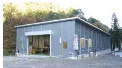
檜原村で稼働する新工場
