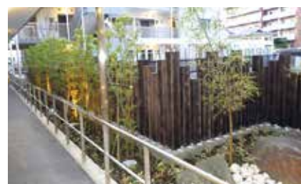
削孔支柱ピン工法による木柵
