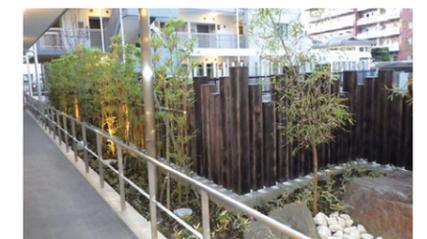
削孔支柱ピン工法による木柵
