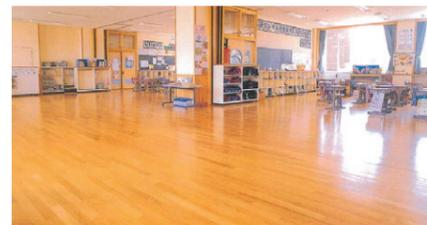
多摩産スギ芯材フローリングの施工例
