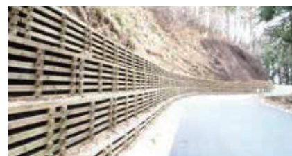
「高耐久木製柵」を使用した土留工
