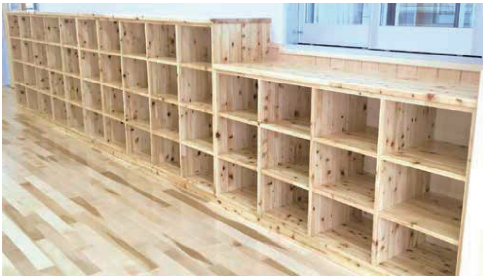
間伐材を用いた台形集成材の学校ロッカー
