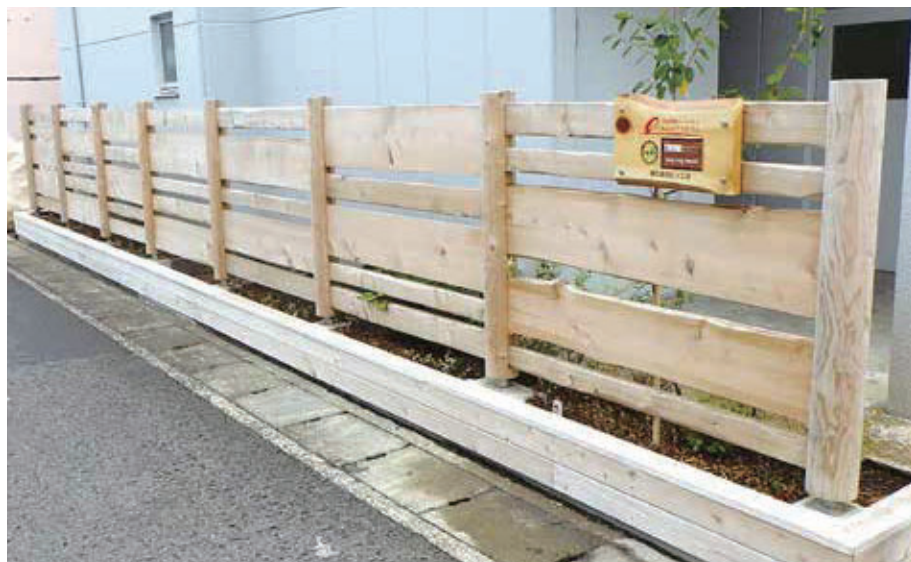
削孔支柱ピン工法による木堀
