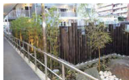
削孔支柱ピン工法による木柵
